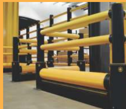
Protetor de Garfo ForkGuard protegendo colunas do guindaste contra a penetração de garfos em uma instalação de manufatura.
