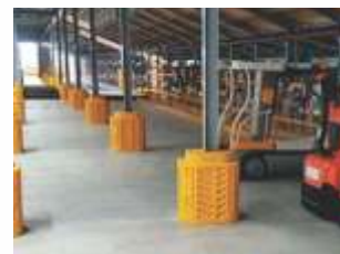
20 Protetor de coluna e cantos
