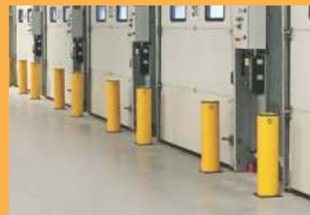
Postes protegendo caixilhos de portas e corredeiras em um centro de distribuição e armazenamento recém-construído.
